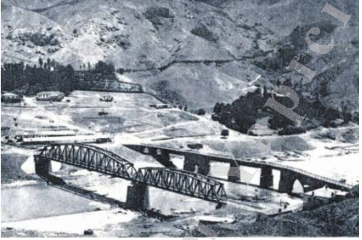
Eski Köprü ve Tren Köprüsü 1945 (Elazığ - Genç Demiryolunun İşletmeye Açılışı Kitabı)
